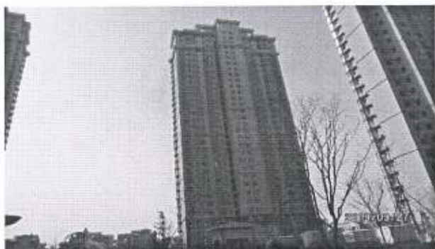
估价对象 1-5 所在楼外景
